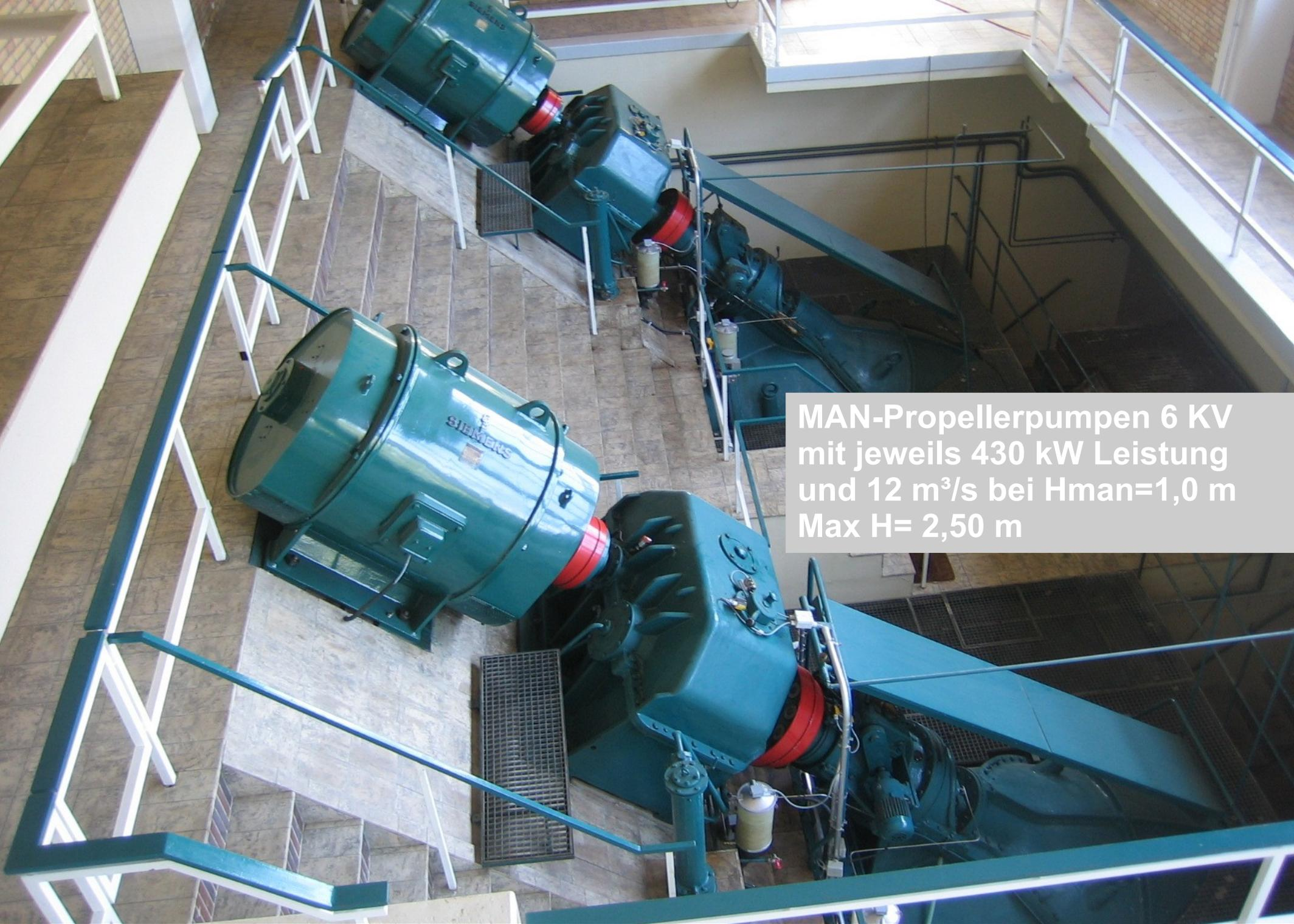
MAN-Propellerpumpen 6 KV
